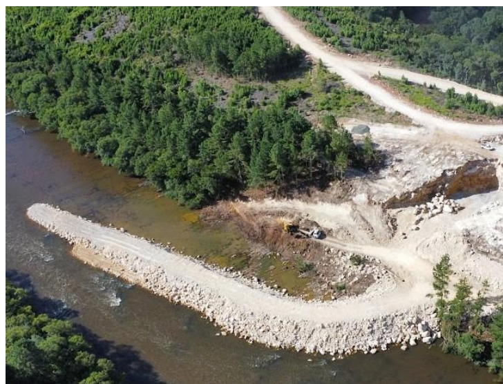
Figura 08: Início do avanço da implantação da ensecadeira Iuri Bayerl 20.jan.2026
