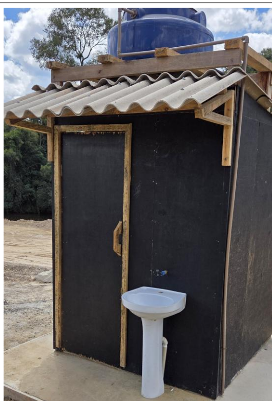
Figura. 11: Sanitário na Obra, com fossa séptica
